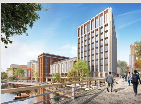
华为上海青浦研发中心 HUAWEI SHANGHAI QINGPU R&D CENTER, ZONE D
