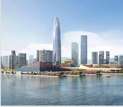
招商太子湾DY03-06项目 CHINA MERCHANTS PRINCE BAY DY03-06 PROJECT
