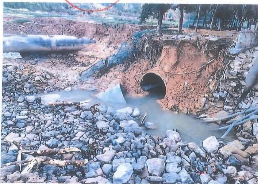
图8 爆管下游侧情况（抽排水后）
