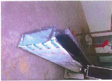
幕墙样品支座和立柱连接的照片
