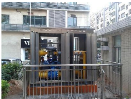
水围村中低压调压箱通气调试
