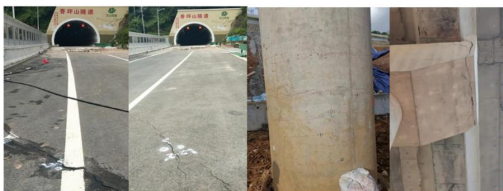
图 1.1-3 桥基斜坡路面及桥墩冒梁病害特征典型照片
