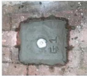
沉降基准点埋设示意图
