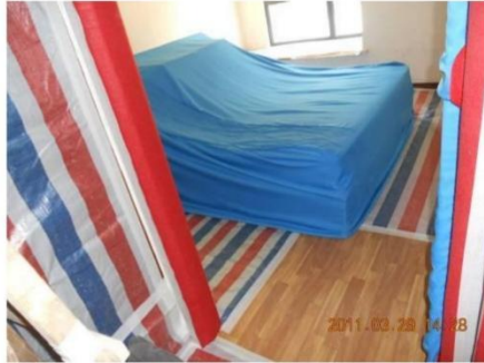
卧室保护图片：开关面板保护图片（中间保护膜、周边美纹纸）：
