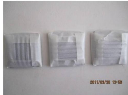
卧室保护图片：开关面板保护图片（中间保护膜、周边美纹纸）：
