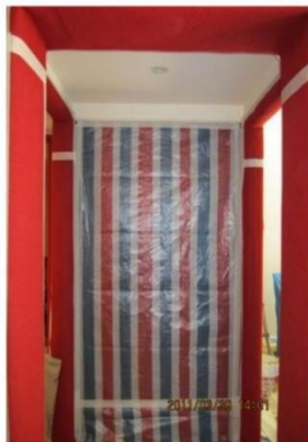
户内门和门框保护图片（门采用成品门套保护、门框采用地毯进行包扎）
