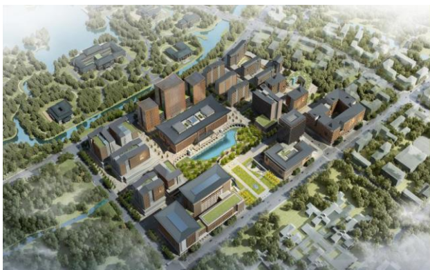
雄安体育中心项目，打造启动区标志性建筑
