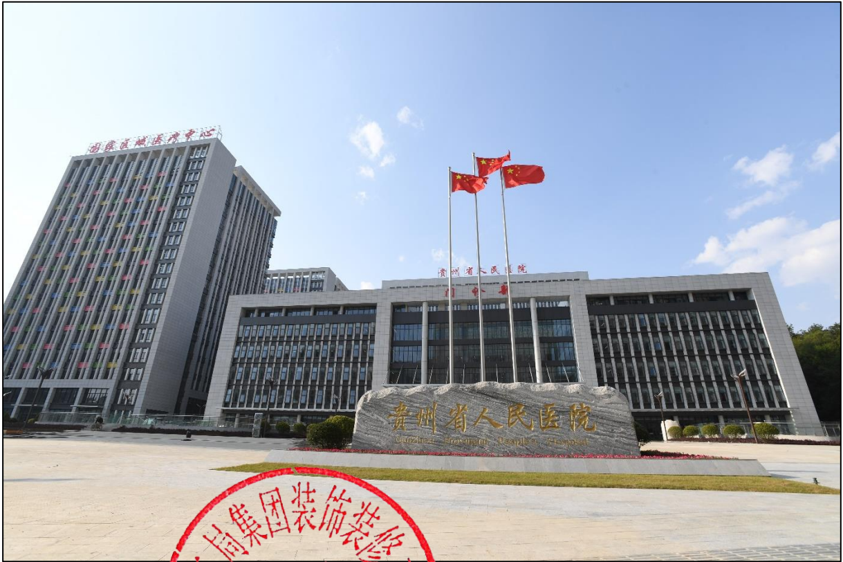
项目实景照片
