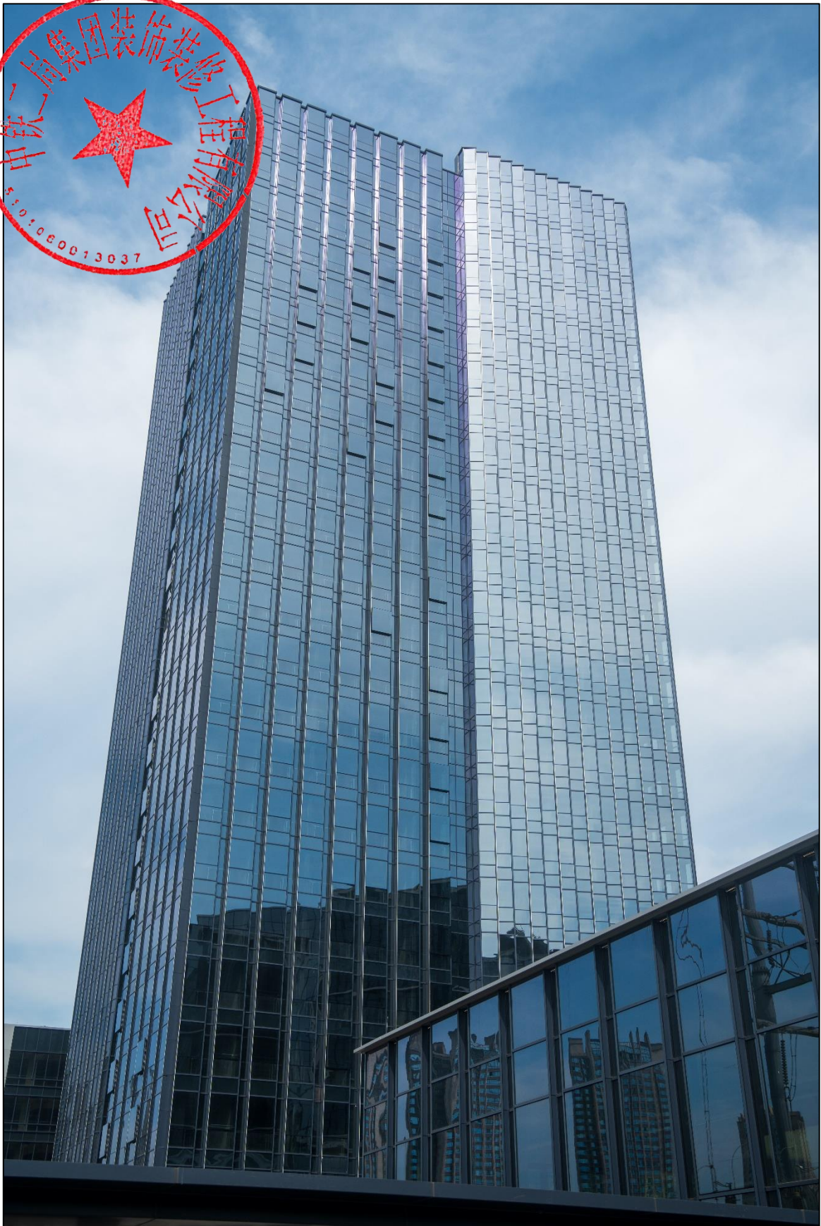
项目实景照片
