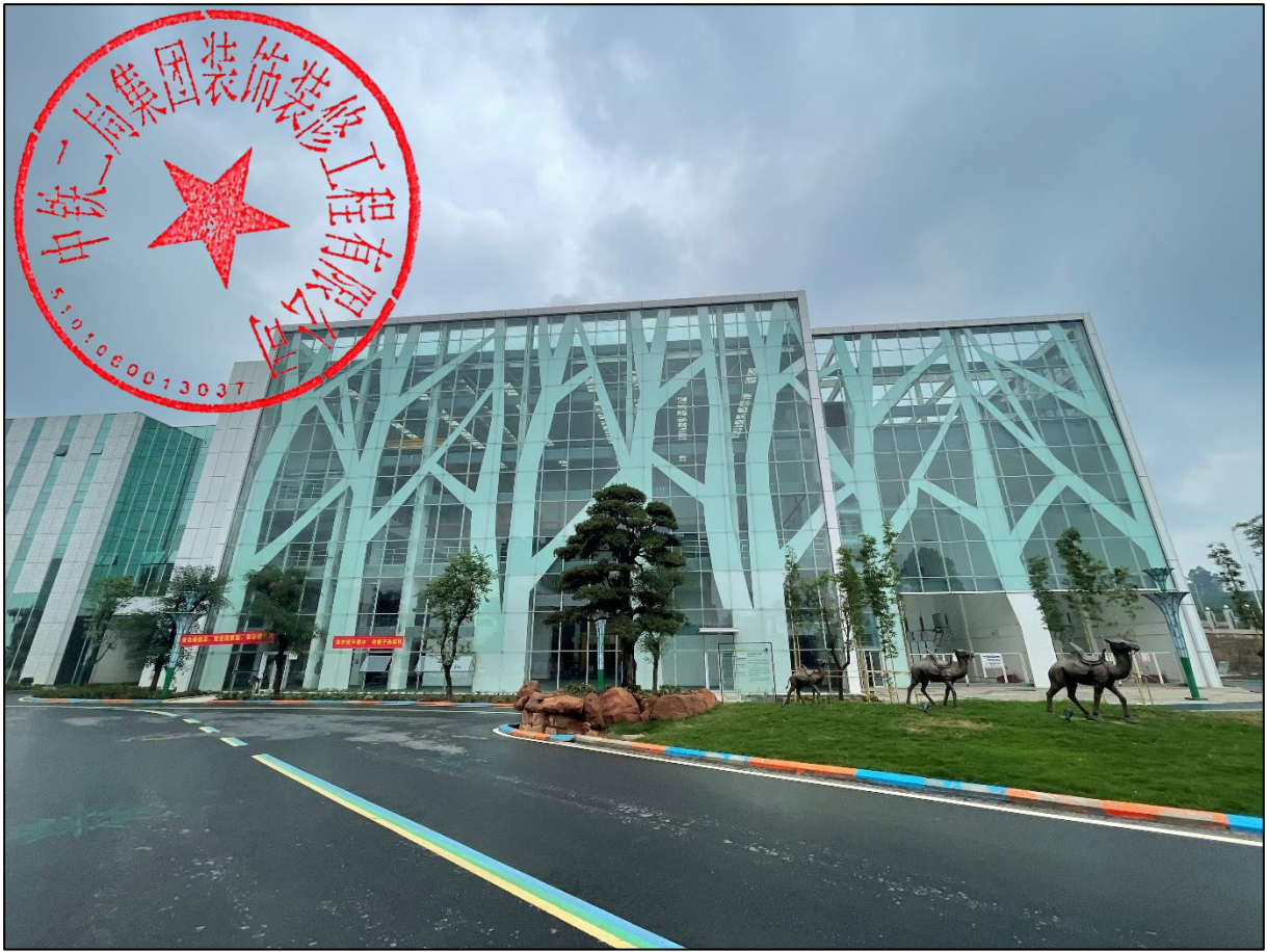
项目实景照片
