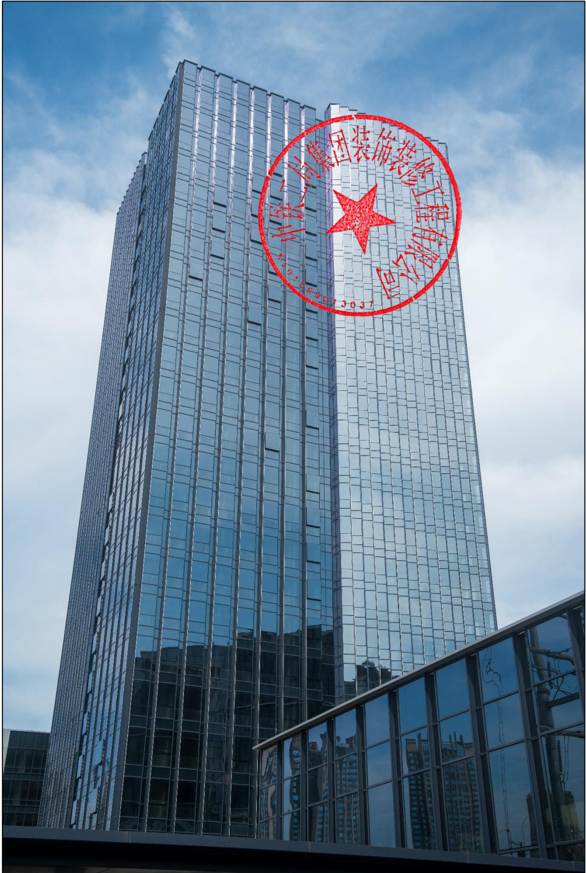
项目实景照片
