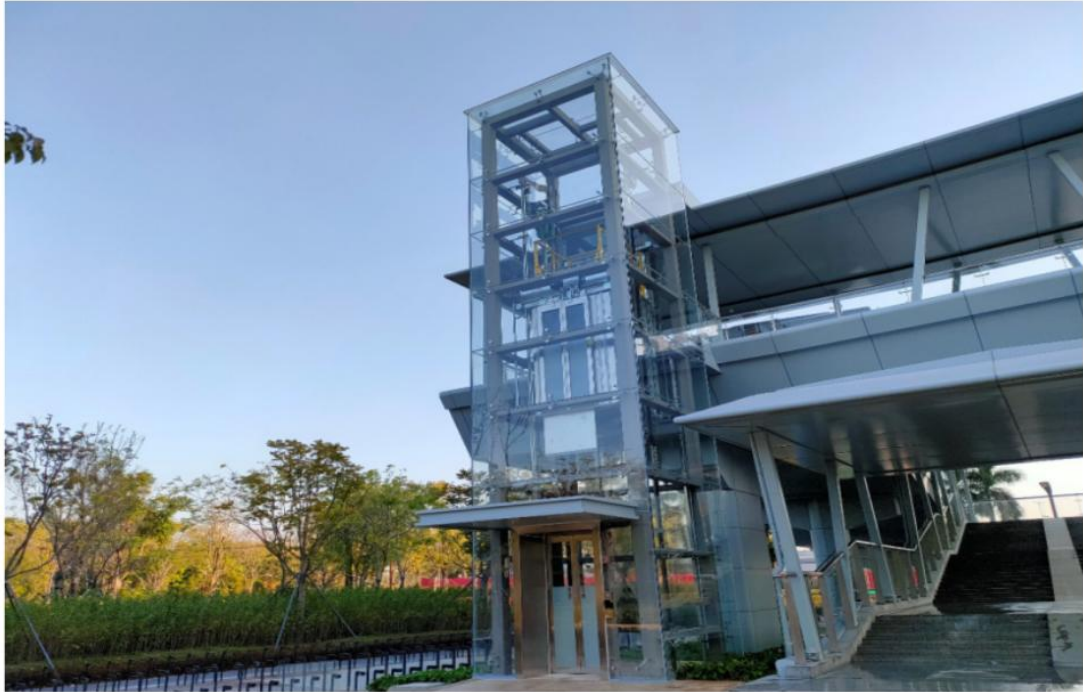
沙河西大冲人行天桥竣工实景图
