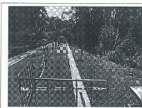
照片 1 边坡现状
