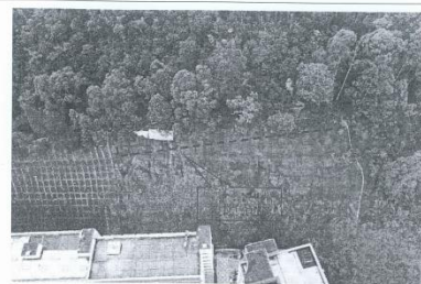
照片1 南段边坡概貌
