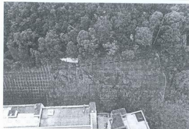
照片1 南段边坡概貌
