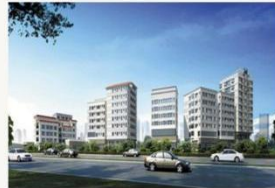
“一河四走廊”沿线城市建筑风貌提升项目立面测绘
