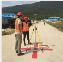
GNSS像控点测绘
