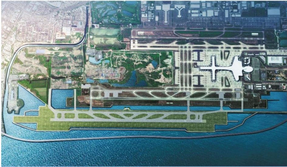
深圳机场第三跑道扩建工程
