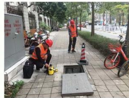
地下管线探测
