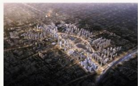
沙井大街（金蚝小镇）重点城市更新单元现状测绘
