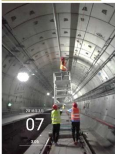
地铁隧道自动化监测点安装
