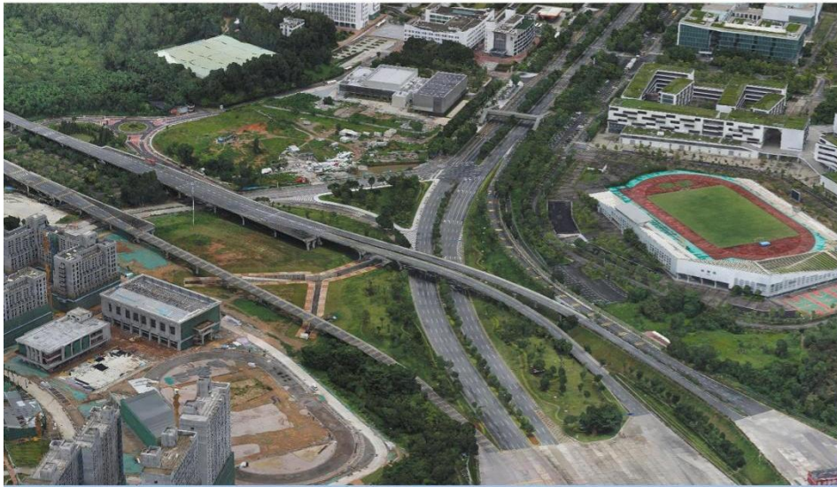
深圳市盐龙大道南段快速工程
