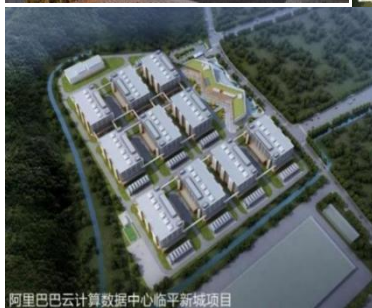
阿里巴巴云计算数据中心临平新城项目
