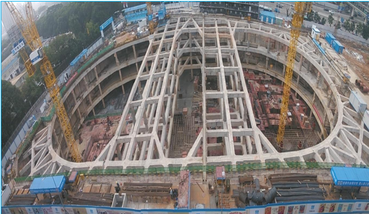
博今商务广场地下公共通道建设工程 施工许可证明： (总监刘汝才)
