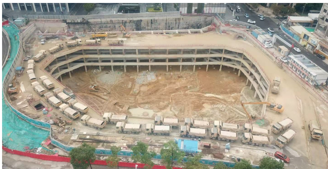
施工现场照片及效果图
