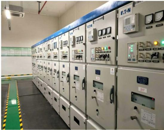
29 间配电室，631 台配电箱柜安装整齐，接地可靠。母线段接线相序正确，绝缘可靠；外观干净整洁，防潮密封良好，编号标识清晰。
