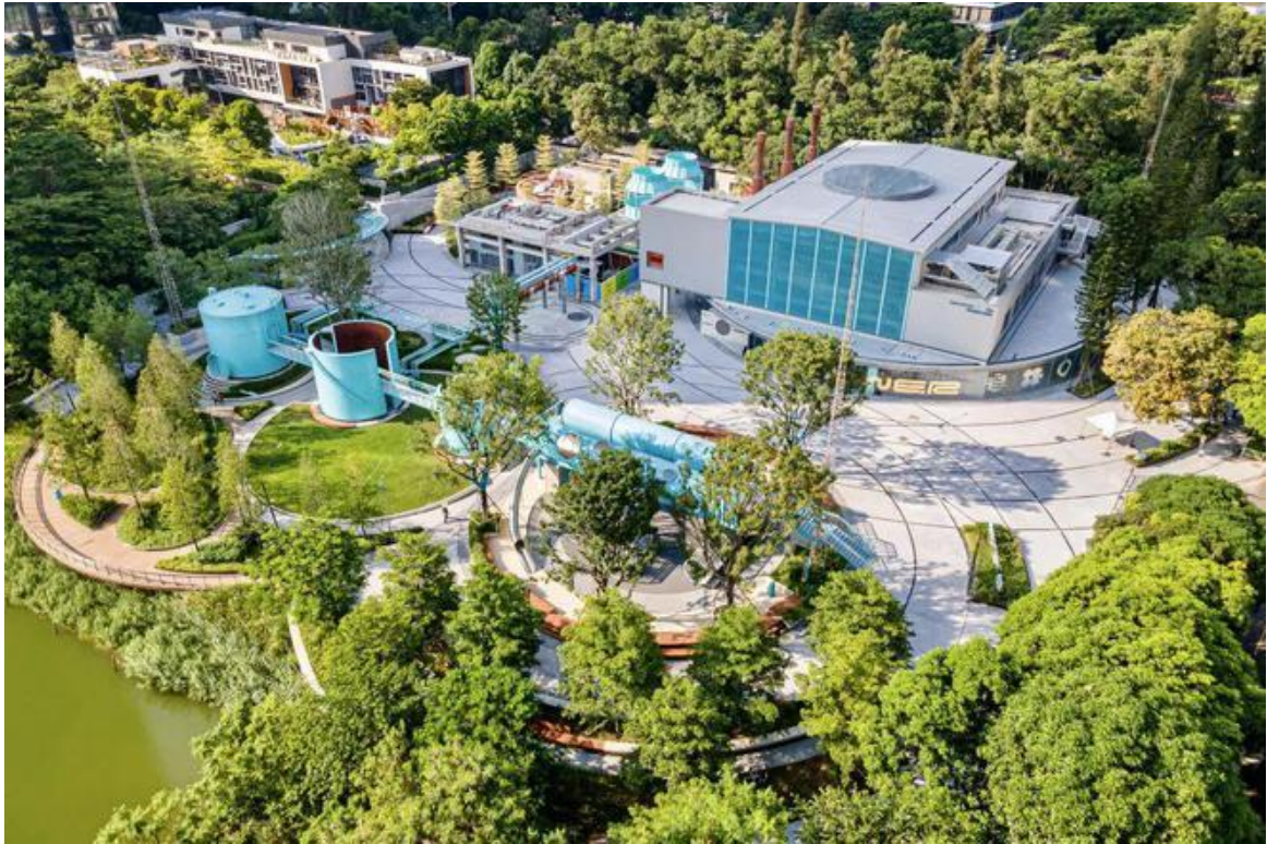
天鹅湖三期改造项目幕墙工程图片
