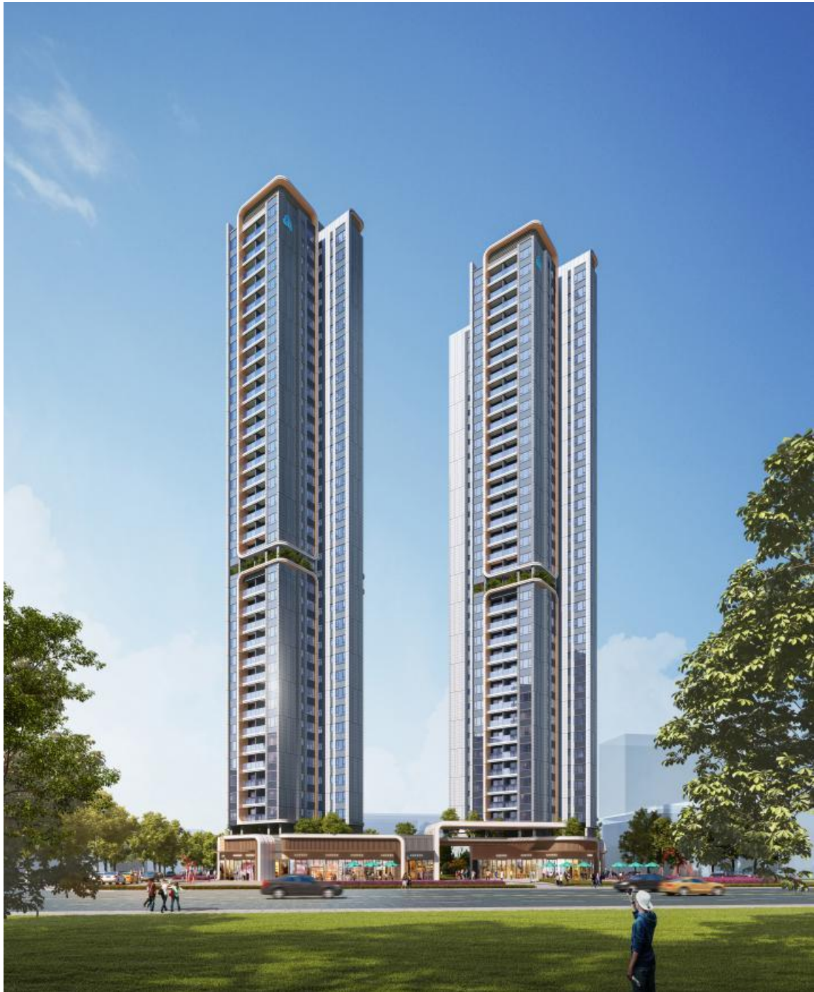
龙岗区宝龙街道 G02310-0001 宗地项目施工总承包-门窗栏杆工程专业分包图片
