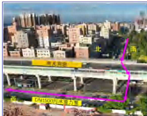
兴路至西环大道 DN1500 污水管顶管施工段下穿南光高速高架桥段
