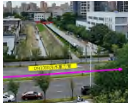
项目振兴路污水主干管工程上石家路-公明南环大道段下穿公明排洪渠河道
