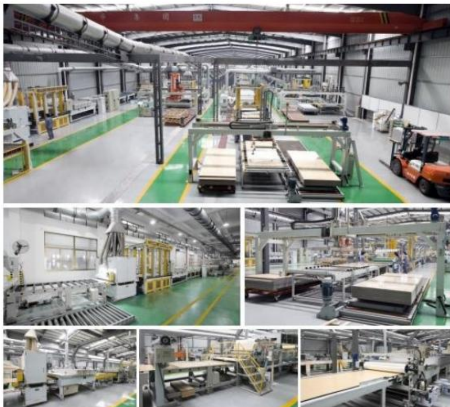
国际领先的无机板预涂装饰板生产线
