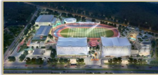
坪山体育聚落地基工程
