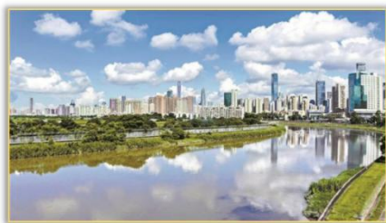
2021 年龙岗区龙岗河流域、观澜河流域、深圳河流域水务工程
