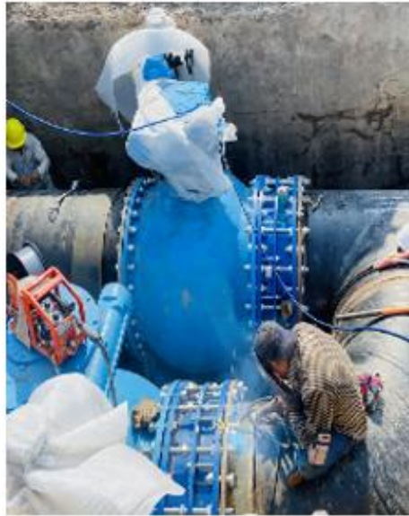
云南昆明 滇中引水工程
