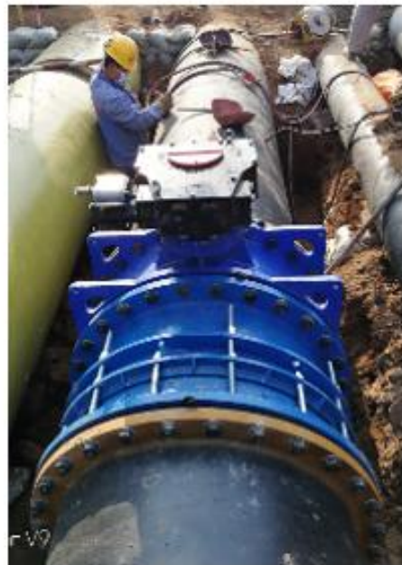
湖南岳阳 城乡供水一体化一期工程
