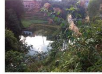
K2+708 大桥桥位现状 1
