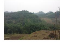
K5+638.102 大桥桥位现状（南岸）
