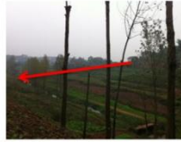
K3+707 大桥桥位现状 2
