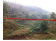
K3+025 大桥桥位现状 2
