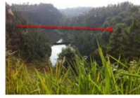
K3+025 大桥桥位现状 1
