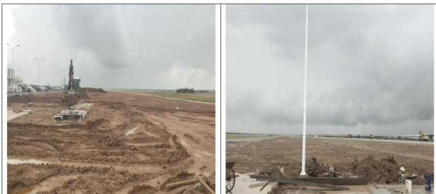
图 4-1、4-2 项目区裸露地表及临时堆土覆盖拦挡措施不全现状
