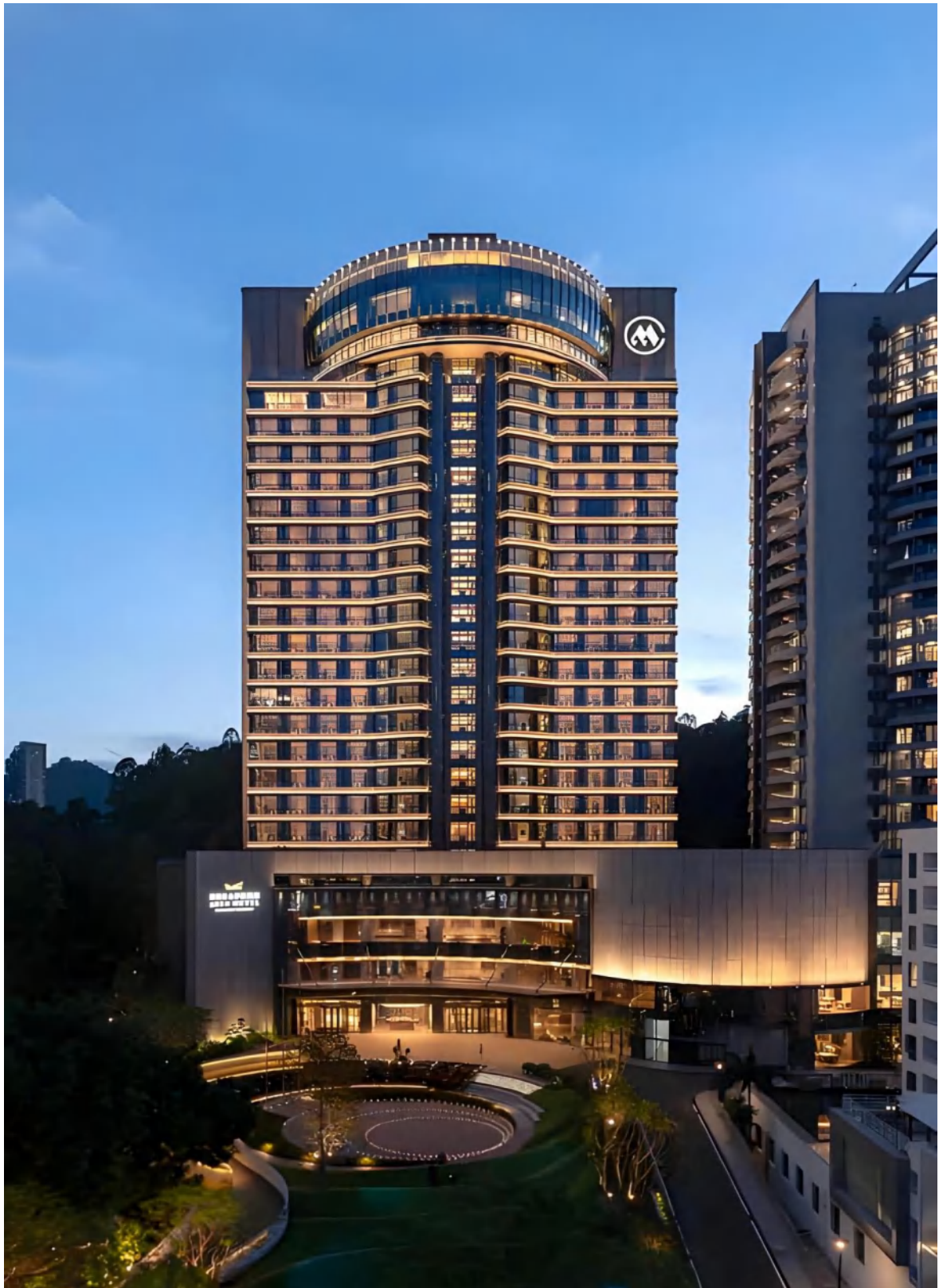
项目实景图项目实景图
