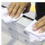
用干净棉布蘸取适量的 异丙醇彻底清洗打胶面
