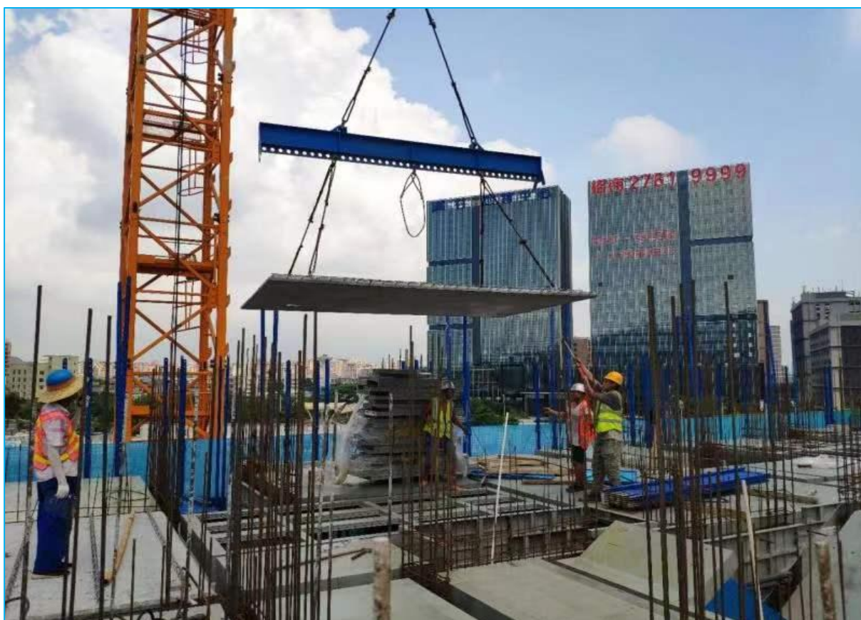
装配式构件施工现场图
