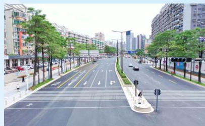
▲ 五和大道品质提升：道路全长约1.08km,为龙华门户形象大道,荣获省优良样板工程
