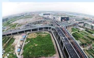
▲ 杭州市东湖快速路德胜立交工程：全长 956 米，快速路采用高架形式，双向六车道，桥梁总长 1612 米，最大单跨 57.5 米，项目获浙江省优质工程奖、钱江杯奖
