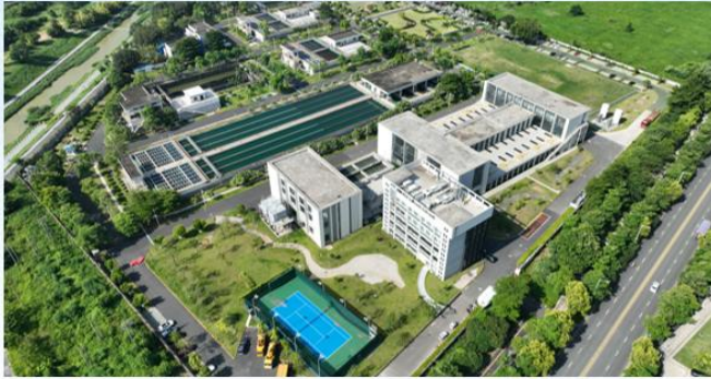
▲ 甲子塘水厂：设计常规净水规模为20万立方米/天，新建深度处理按照设计规模20万立方米/天，采用臭氧-活性炭深度处理工艺及污泥处理系统
