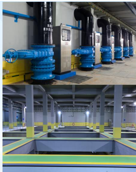
布吉污水处理厂 工程规模为 20 万立方米/天， 全国首座全埋地式、首次采用 创新型双层沉淀池技术，工程 占地面积 5.95 公。曾获2012 年度全国市政金杯示范工程、 第十一届中国土木工程詹天佑 奖、2012-2013年度中国建设 鲁班奖
