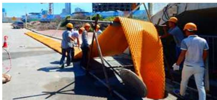
给排水管道非开挖垫衬法施工
