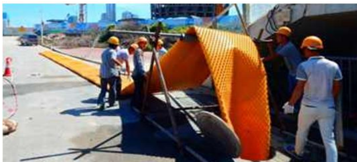
给排水管道非开挖垫衬法施工
