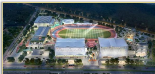
坪山体育聚落地基工程
