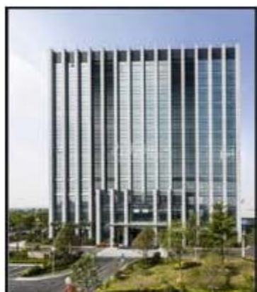
上海市青浦区恒润大厦
