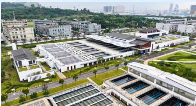
▲ 五指耙水厂：扩建 14 万立方米1天的常规水处理工程、新建 30 万立方米/天深度及排水回收处理工程、现状生产设施配套升级改造、配套厂内道路和景观、现状立面改造等
