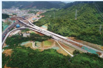
◆ 东部过境高速公路：第六合同段桥梁历时54天完成5座桥梁 194 片箱梁的运输、架设单梁最远运输里程 120Km;获深圳市交通运输局通报嘉奖函
