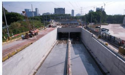
观盛二路-大和路下穿隧道及连接工程：隧道工程共790米，其中U型槽长190米，明挖隧道长355米，暗挖隧道长245米。项目暗挖段需下穿梅观快速路，隧道埋岩等级为VI级，隧道埋深约9m，为复杂环境大断面浅埋暗挖矩形隧道开挖施工。
