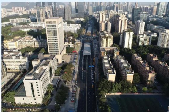
▲ 南海大道下穿工程：道路全长约1.25公里，采用“明挖法+浅埋暗挖”施工工艺
