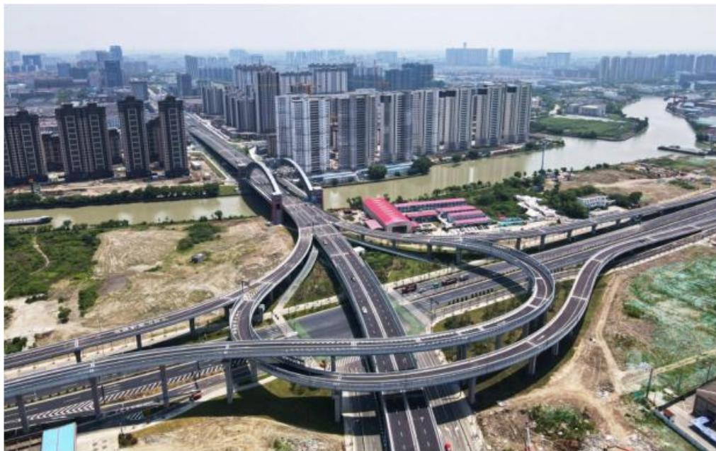
南林大桥横跨长湖申航道、连接𬱖塘南北两岸，是南浔新老城区串联的重要交通枢纽，也是城市主轴线贯通的关键组成部分。改建后的南林大桥，主航道桥全长 917 米，桥梁整体升高至 10.12 米，升级为双向六车道，下挂非机动车道，实现人车完全分流。道路南北向全线长约 1.66km，道路东西向全线长约 1.82km，总投资约 8 亿元。
