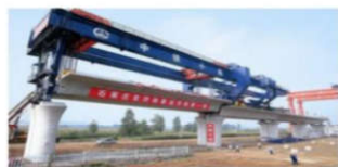
中铁石济客专铁路项目
