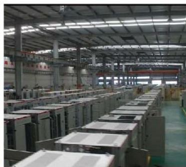
智能电力产品装配现场
