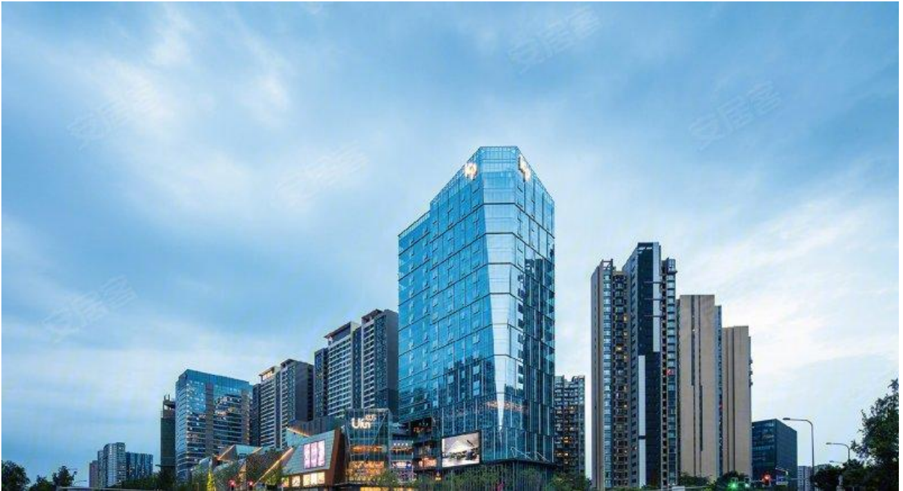
建筑高度 100m，建筑面积 25 万平方米，业态：写字楼、商业综合体
