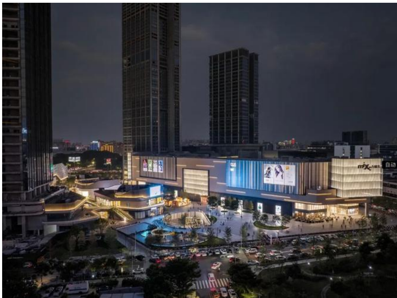
建筑高度 100m。建筑面积 28 万平方米，业态：办公写字楼、商业
