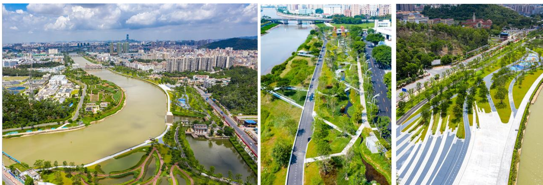
茅洲河碧道试点段建设项目（宝安段）示范段IV标段、标准段 I 标段
