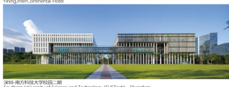
深圳-南方科技大学校园二期 Southern University of Science and Technology (SUSTech), Shenzhen
