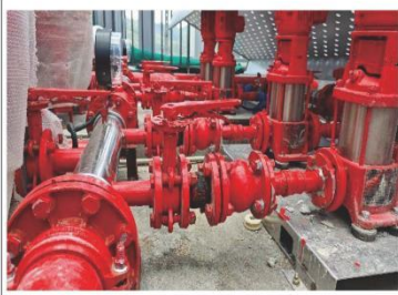
高位消防水箱
