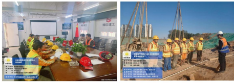
图 1.10.3-1-2 勘察施工之前进行专项安全、技术交底
