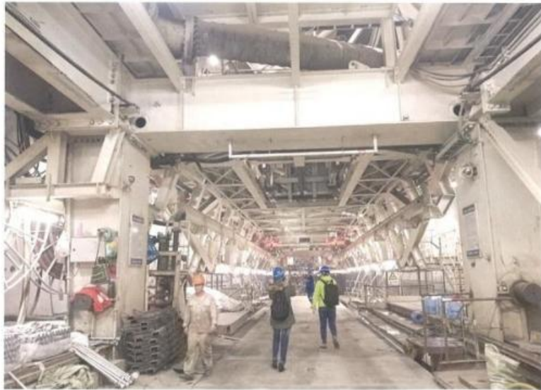
项目审核人员参观上海沿江通道越江隧道
