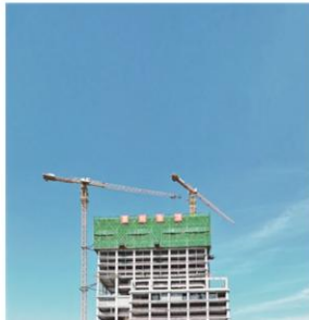
青岛国际邮轮港区航运中心项目建设现场。
