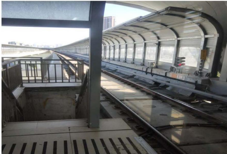
地铁现场实景
