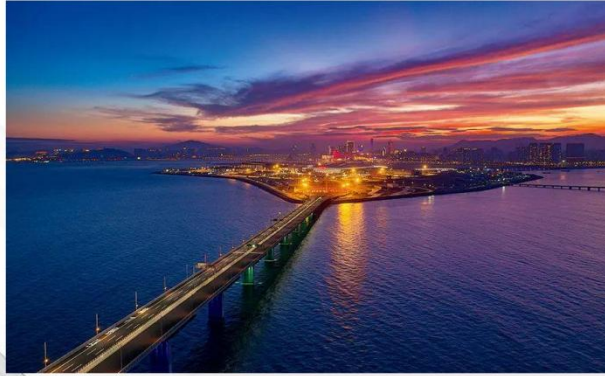
港珠澳大桥人工岛
