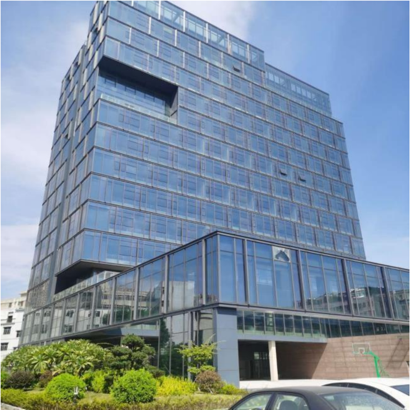
在建办公大楼
