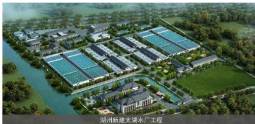
湖州新建太湖水厂工程
