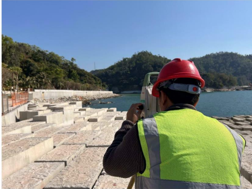
图 2 东部海堤现状（沙鱼涌）
