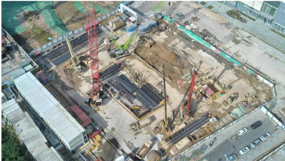
图 1.1 项目现状图（拍摄于 2024 年 01 月 02 日）
