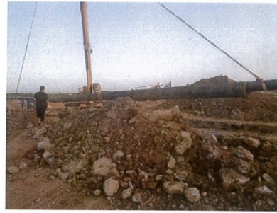
临时便道管段加装套管
