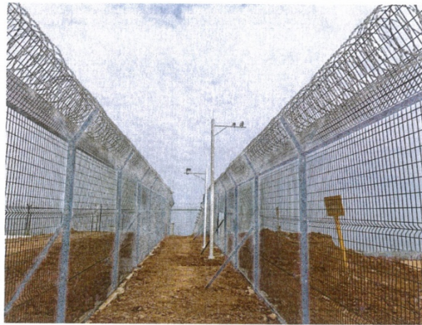
北端坡顶处安装枪机补盲
