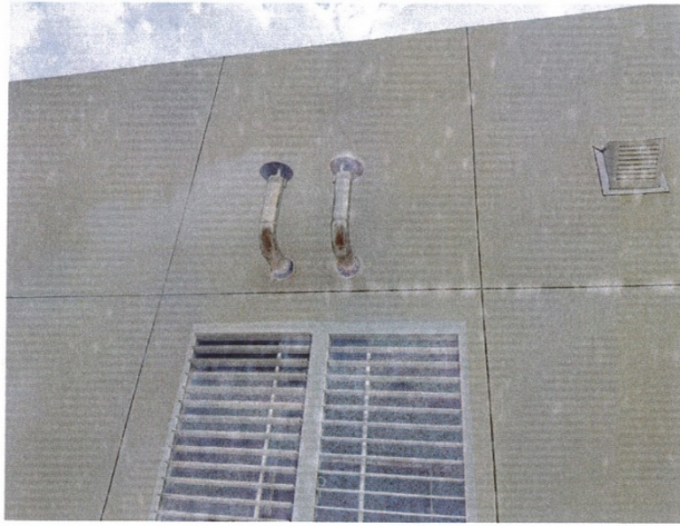
油机排烟管整改
