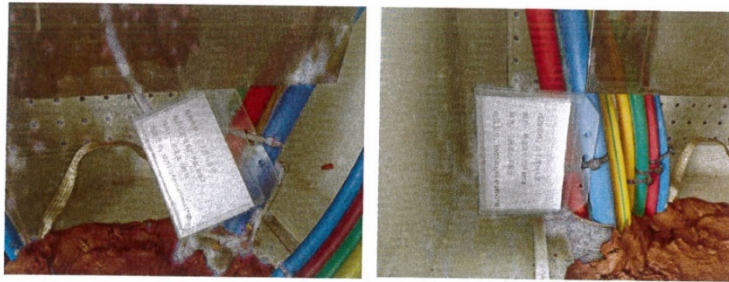
主机柜主电源线打标识卡
