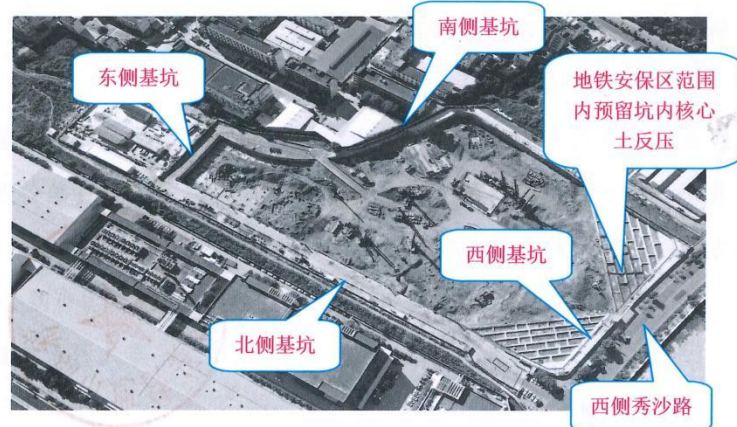
图 3: 现场航拍照片
